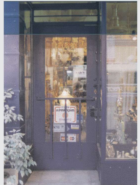
בית דבורה חיסקינד שינגרטן, דיזנגוף 184 תל-אביב 1935, אדריכל לא ידוע דוגמה לדלת שקועה.
